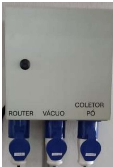
Figura 5 – Quadro elétrico – previamente instalado
