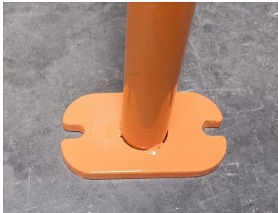
Figura 9 - Fixação dos pés dos varões
