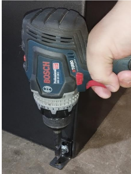
Figura 8 - Fixação do parabol
