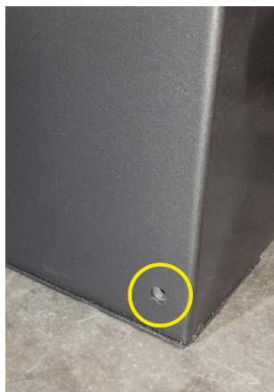
Figura 7 – Ponto de fixação da cantoneira de chumbamento
